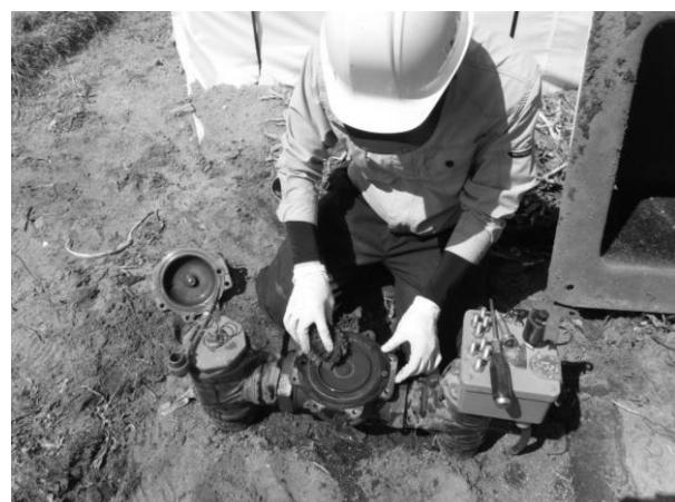
写真3 電磁弁の分解点検
